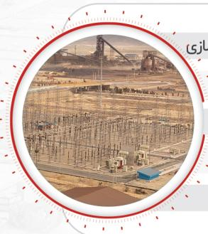
**محصول کارخانه** ▶ تبدیل برق ۴۰۰ به ۳۳ کیلووات برای تغذیه کارخانه های احیا و فولادسازی
