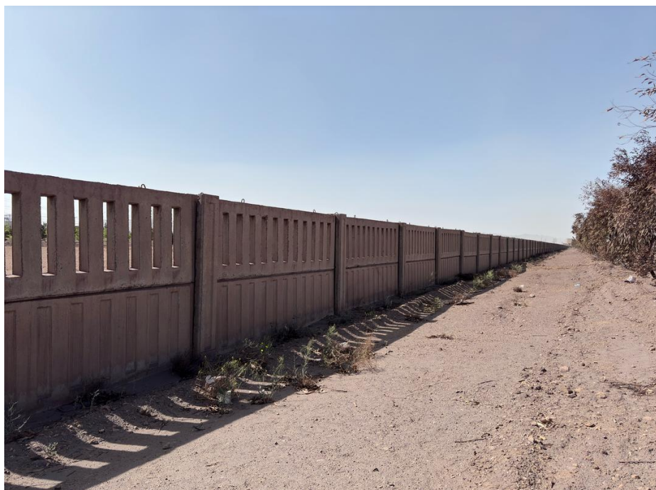
عکس های وضع موجود دیوار های پیرامونی
